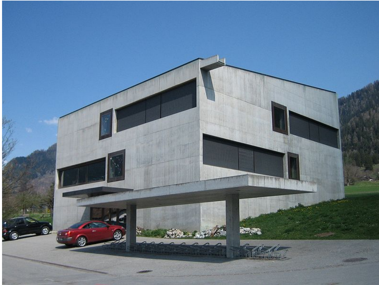
Oberschulgebäude in Paspels (1998)
