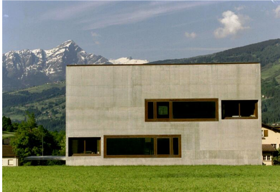
Oberschulgebäude in Paspels (1998)
