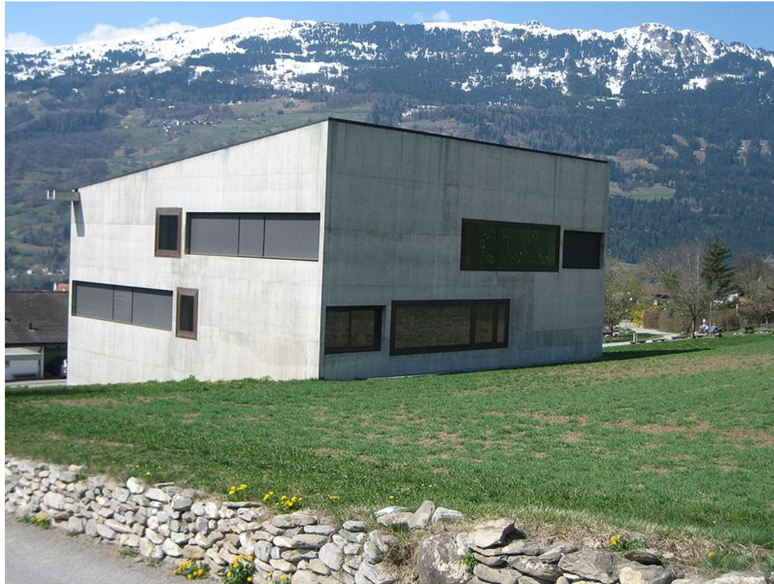
Oberschulgebäude in Paspels (1998)
